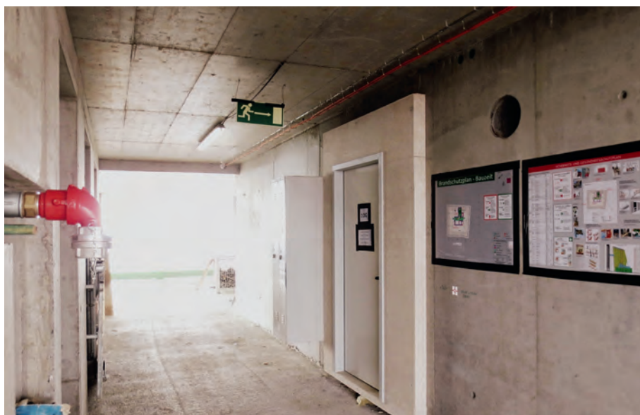
Abb. 4: Brandschutztechnische Maßnahmen während der Bauzeit.
