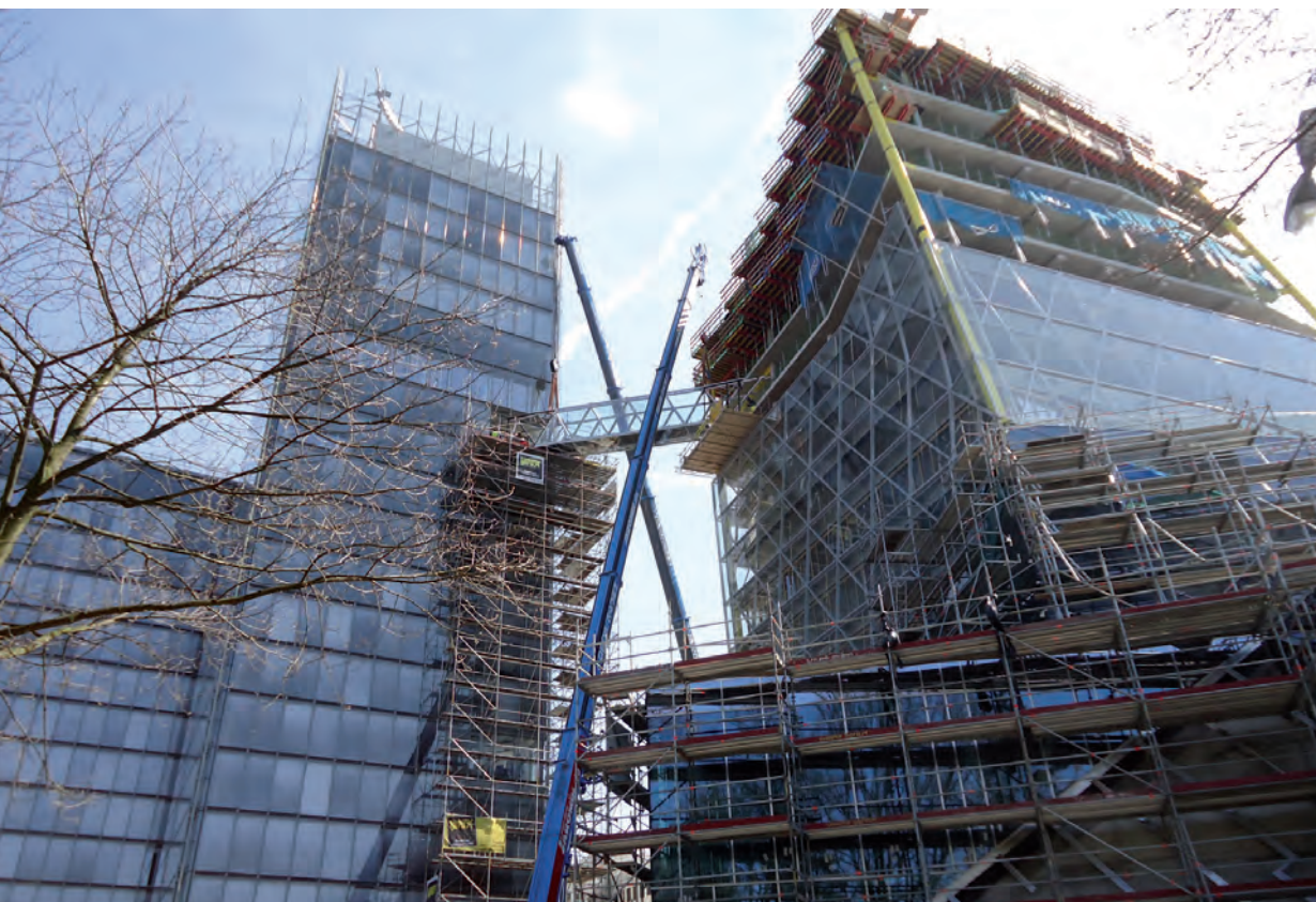
Abb. 1: Errichtung der gläsernen Brücke zwischen den beiden Hochhäusern.
